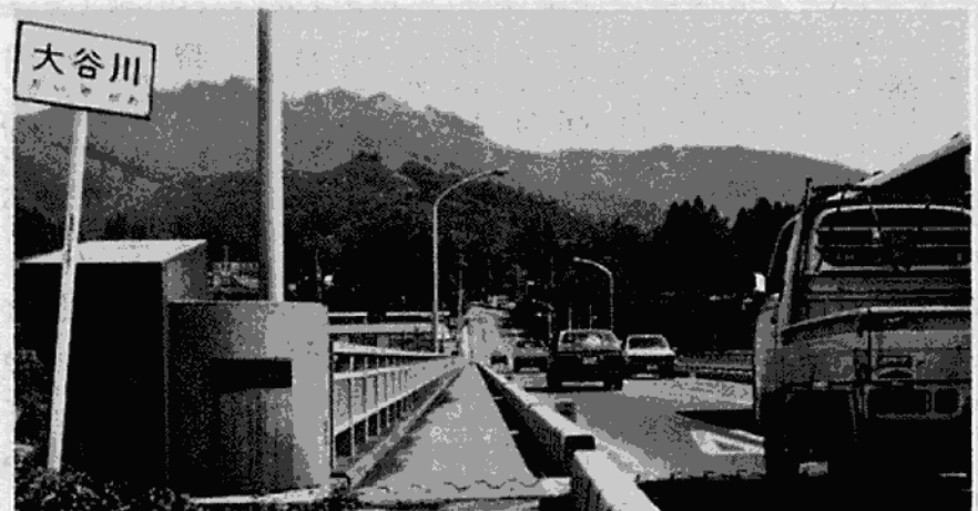
完成した歩道
