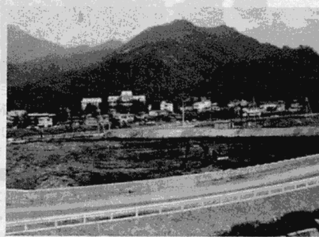
造成工事の終わった敷地
