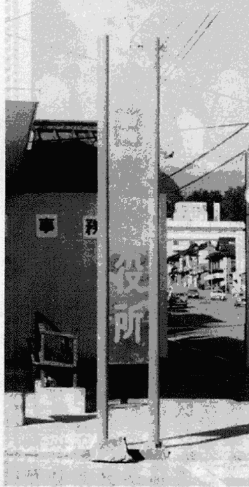
完成した立看板
