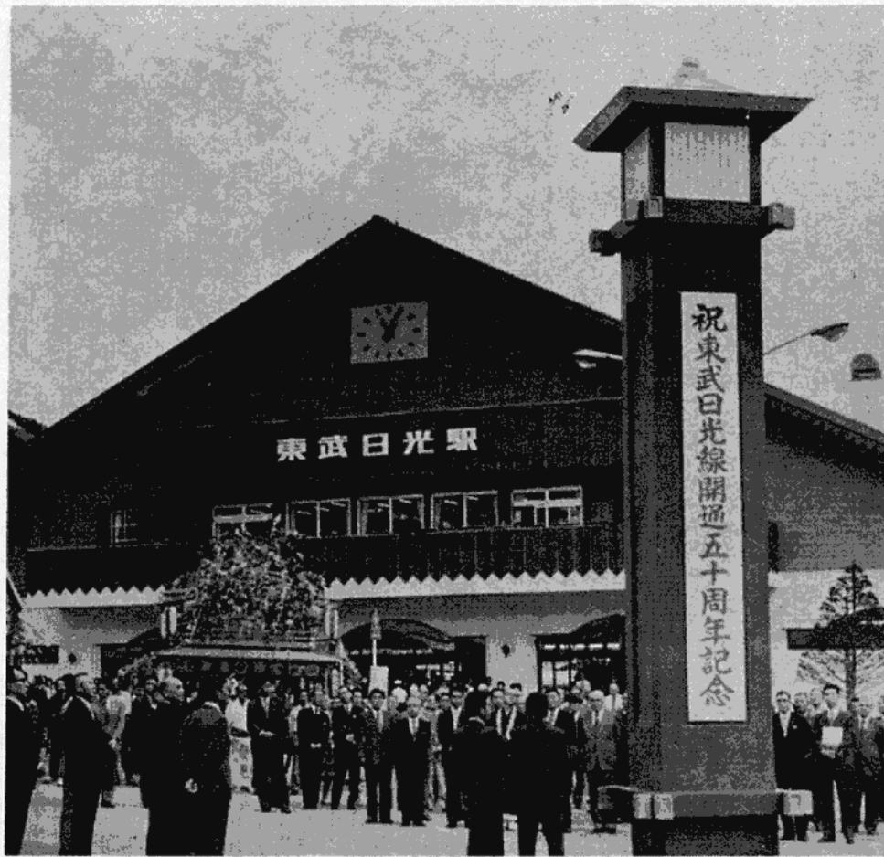
完成した東武日光新駅舎と歓迎塔
