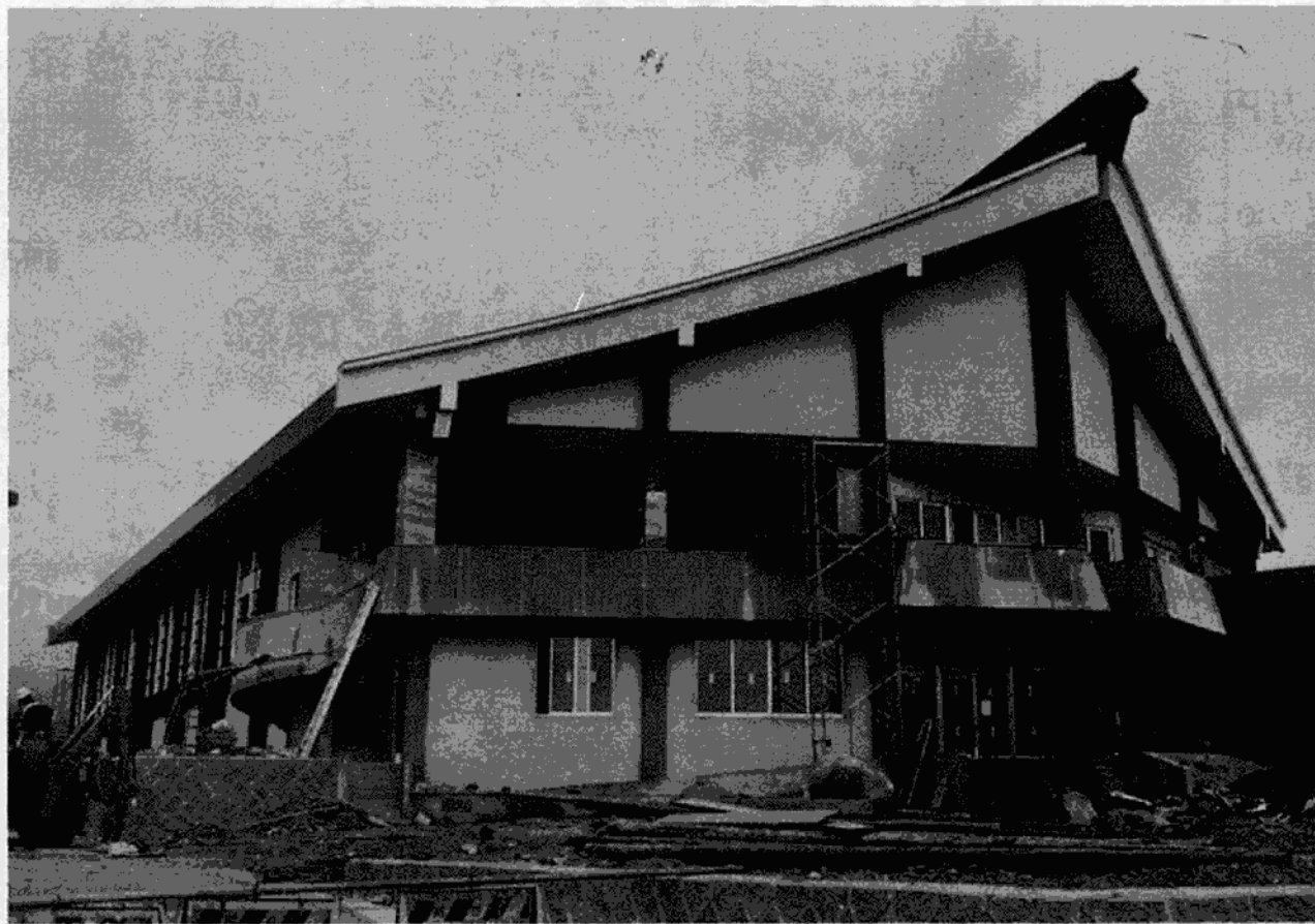
竣工間近な日光市体育館
