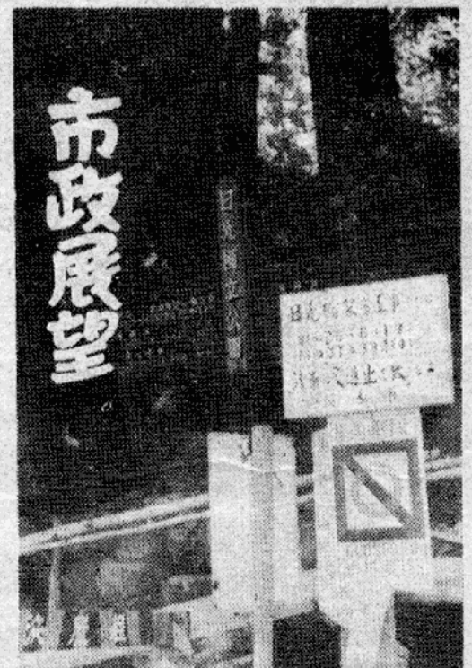
(工事のはじまつた日光橋)
