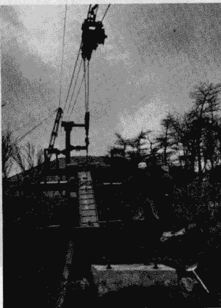
第三リフト2号線の新設工事
