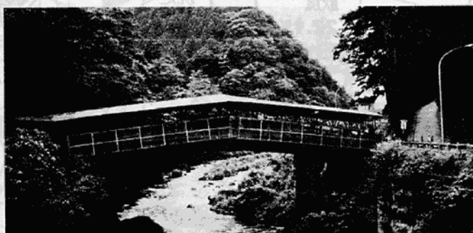
修理が始まった神橋
