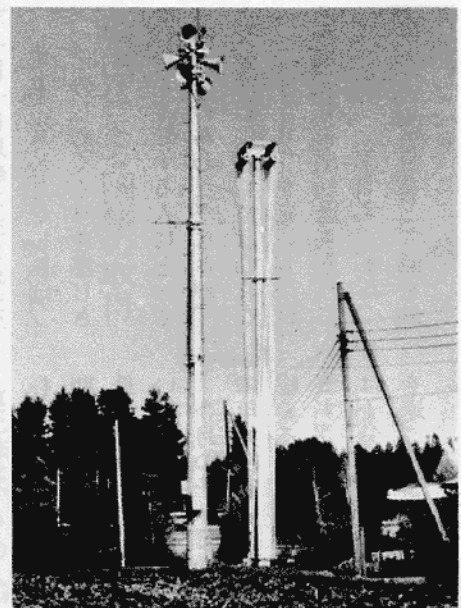
完成した遠隔装置付きサイレン。非常のときは、消防本部のボタン操作で吹鳴できる。
