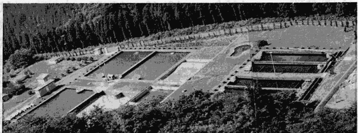
安良沢じょう水場
