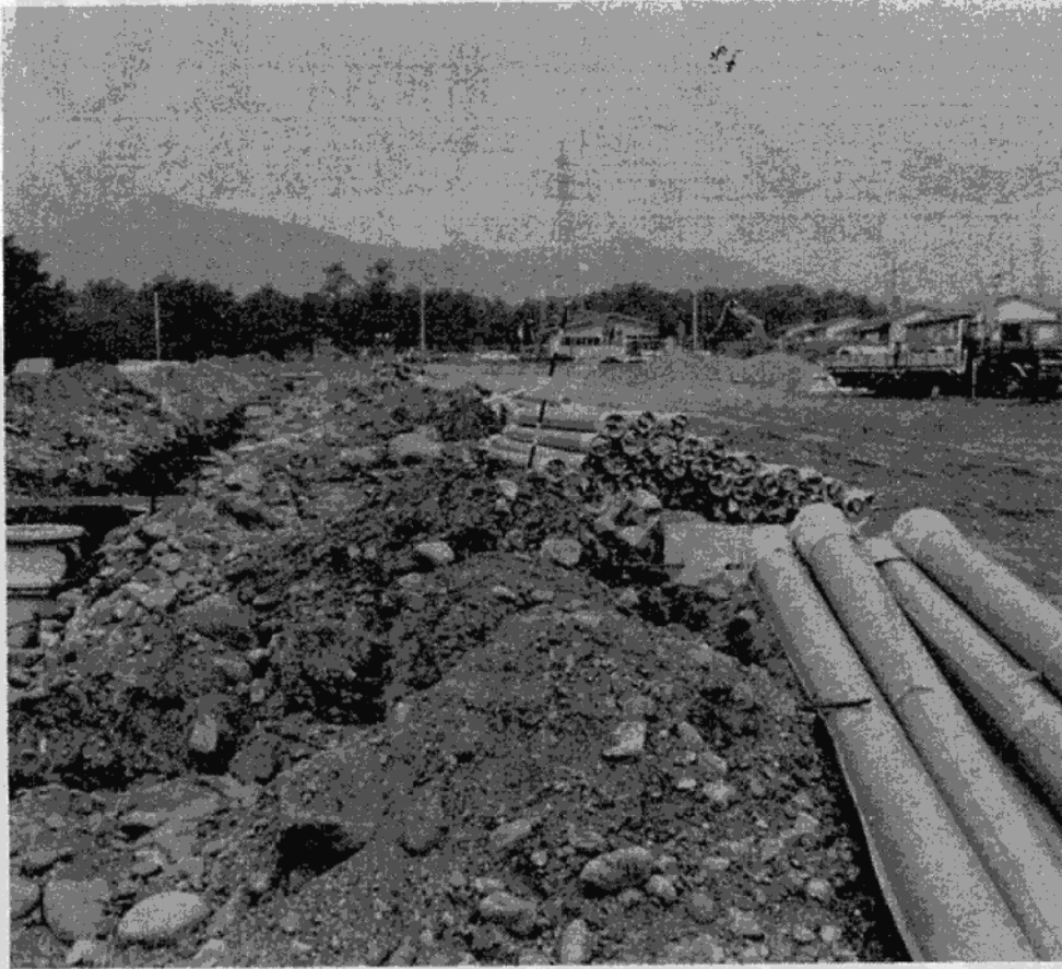
造成工事進む分譲地
