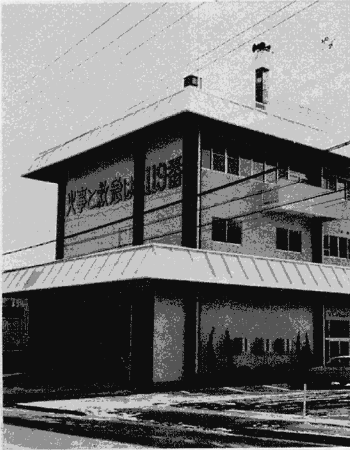
完成した消防庁舎
