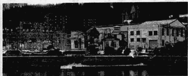
現在の日光発尾尾発電所
