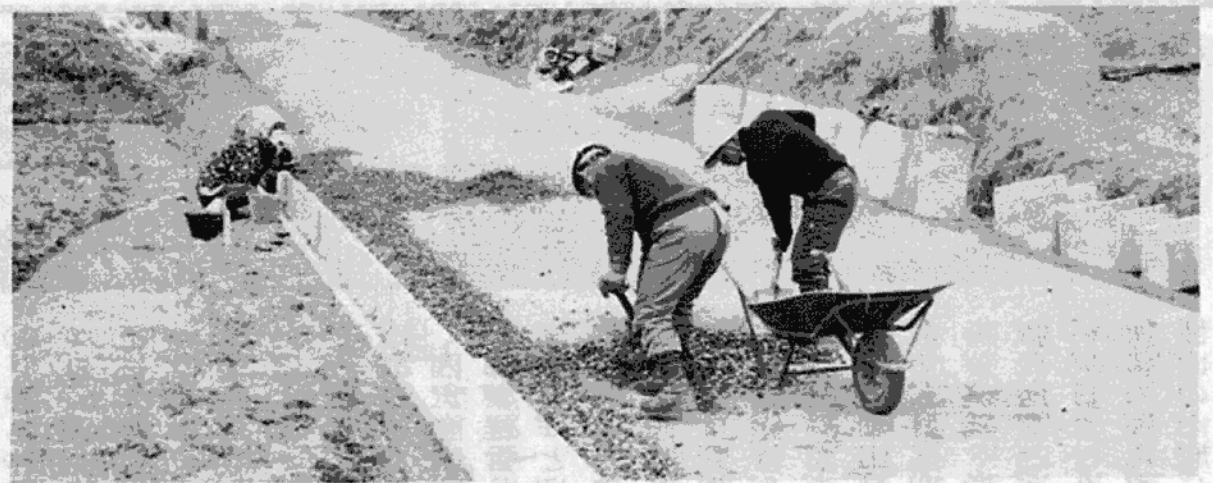
舗装整備が進む農道
