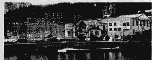
日発細尾発電所
