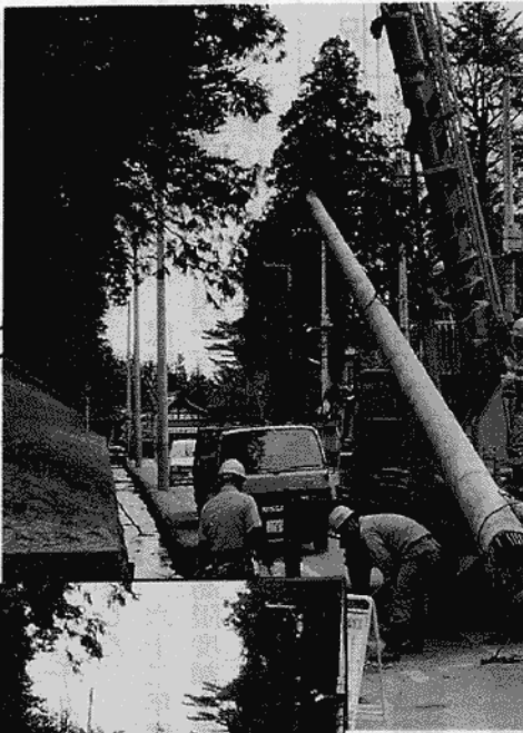
撤去される電柱と撤去後
