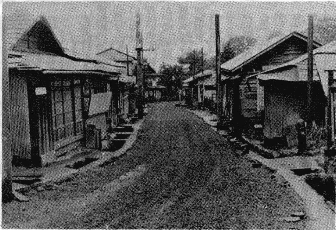
舗装工事を始めた市道1号線
