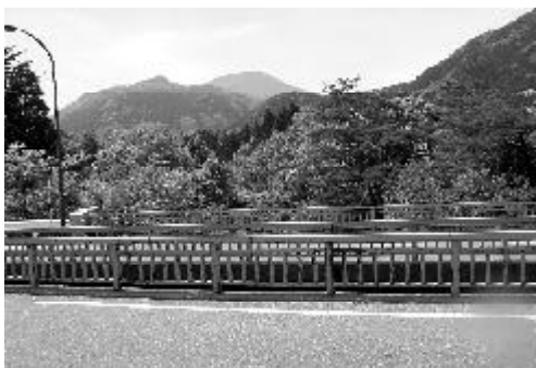
現在の安良沢橋周辺
